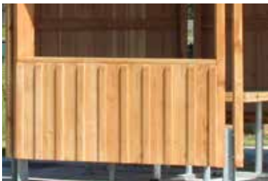
Detail - Brüstung-Deckelschalung
