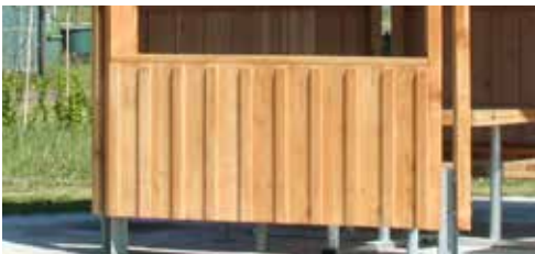
Detail - Brüstung-Deckelschalung
