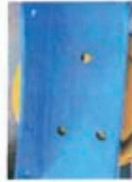
Montageträger (U-Profil) auflegen und mit Schloßschrauben, Unterscheibe, Federring und Mutter verschrauben.
