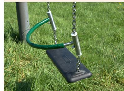
Stahlbügel als Absprungsicherung
