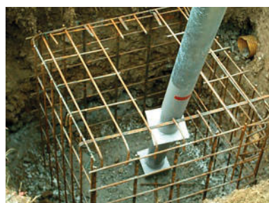
Seilbahnfundament Bewehrung erforderlich (bauseits - nicht im Lieferumfang)
