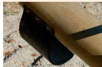
Stoßdämpfer: aus textilverstärktem Gummi
