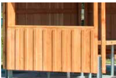
Detail - Brüstung-Deckelschalung
