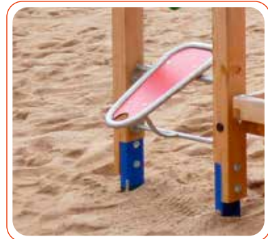
Feuerverzinkte, pulver- beschichtete U-Profil- Pfostenschuhe.
